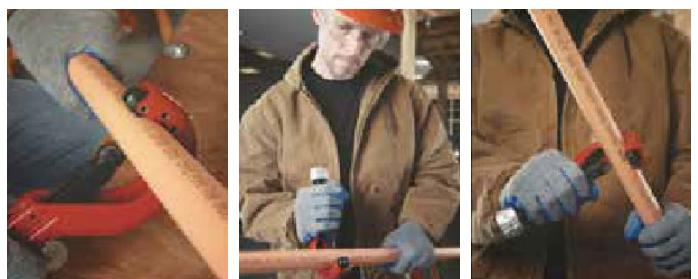
Ống BlazeMaster dễ dàng cắt bằng máy cắt bánh cóc, máy cắt ống nhựa dạng bánh xe, máy cưa điện hoặc máy cưa răng mịn - không sử dụng lưỡi cắt cùn hoặc bị gãy. Để đảm bảo ống được cắt vuông góc, hãy sử dụng hộp cắt góc khi cắt bằng máy cưa tay. Cắt ống vuông góc nhất có thể sẽ cung cấp diện tích bề mặt liên kết tối đa.
