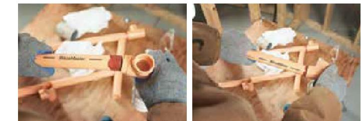
Ngay sau khi sử dụng dung môi, lắp ống vào phụ kiện và xoay ¼ vòng cho đến khi đạt đến điểm dừng của phụ kiện. Phụ kiện phải được căn chỉnh đúng cách để lắp đặt tại thời điểm này và ống phải chạm vào đáy phụ kiện.
